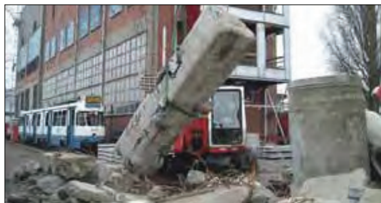
Het gebouw op de Zuidergasfabriek werd uitgebreid met allerlei objecten om alle voorkomende incidenten te kunnen beoefenen, tot oude trams aan toe.
